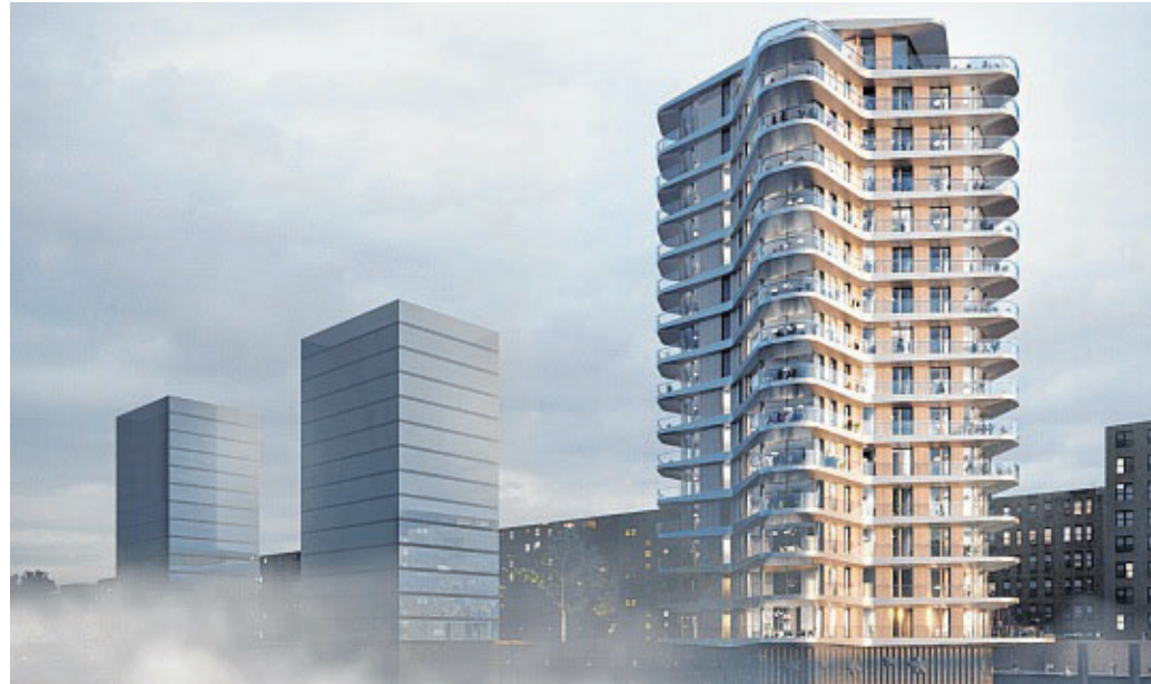
Im westlichen Wasserturm entstehen 62 Wohnungen. Die gerundeten, metallischen Deckenränder sind je nach Tiefe der Auskrugung unterschiedlich breit. Entwurf: Ludger Inholte Projektentwicklung
